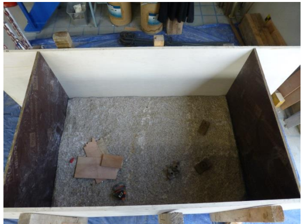
6 - Coffrage du demi-bloc inférieur, retourné face rugueuse vers le haut
