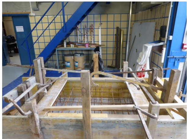
4 - Coffrage du bloc rocheux et mise en place du ferrailage de la base en béton
