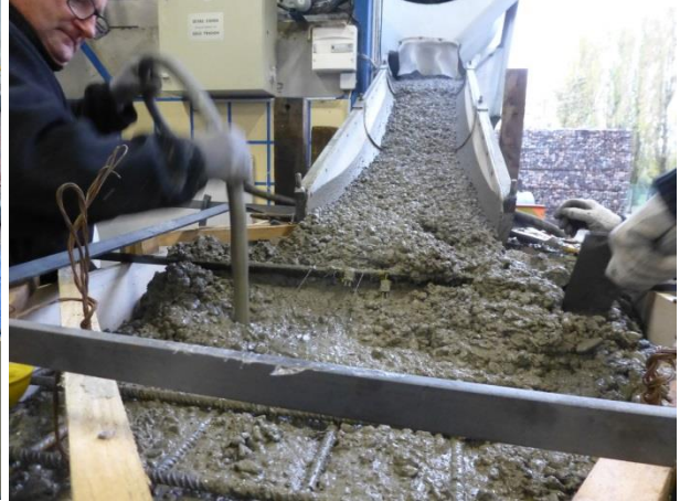
8 - Coulage du béton du demi-bloc supérieur
