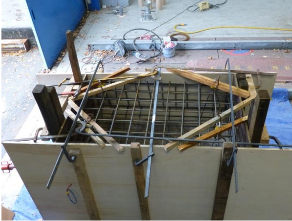
7 - Mise en place du ferrailage du demi-bloc supérieur
